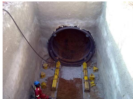
The 3000 mm OD jacking shield
