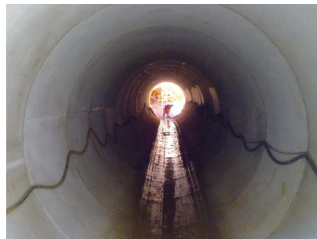
The 3000 mm OD jacking shield
